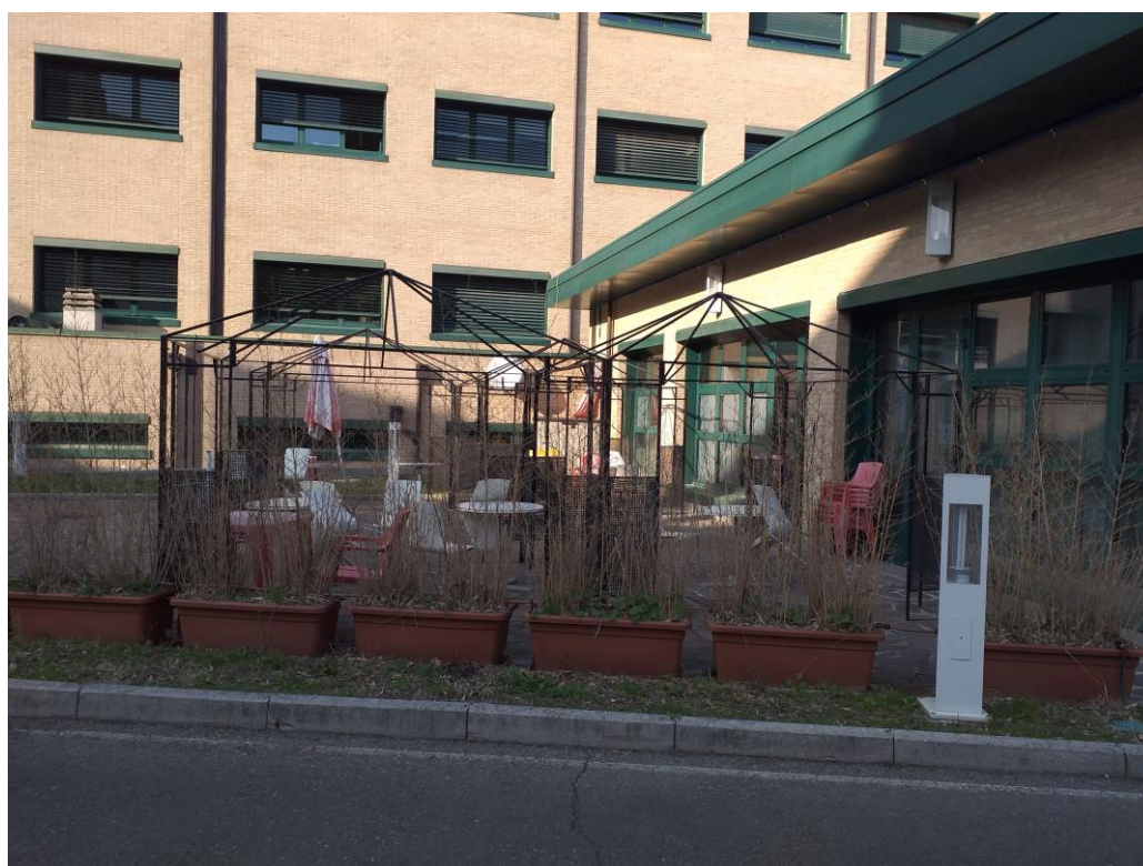
Foto 4 – Area esterna all’ edificio dedicata al Bar
