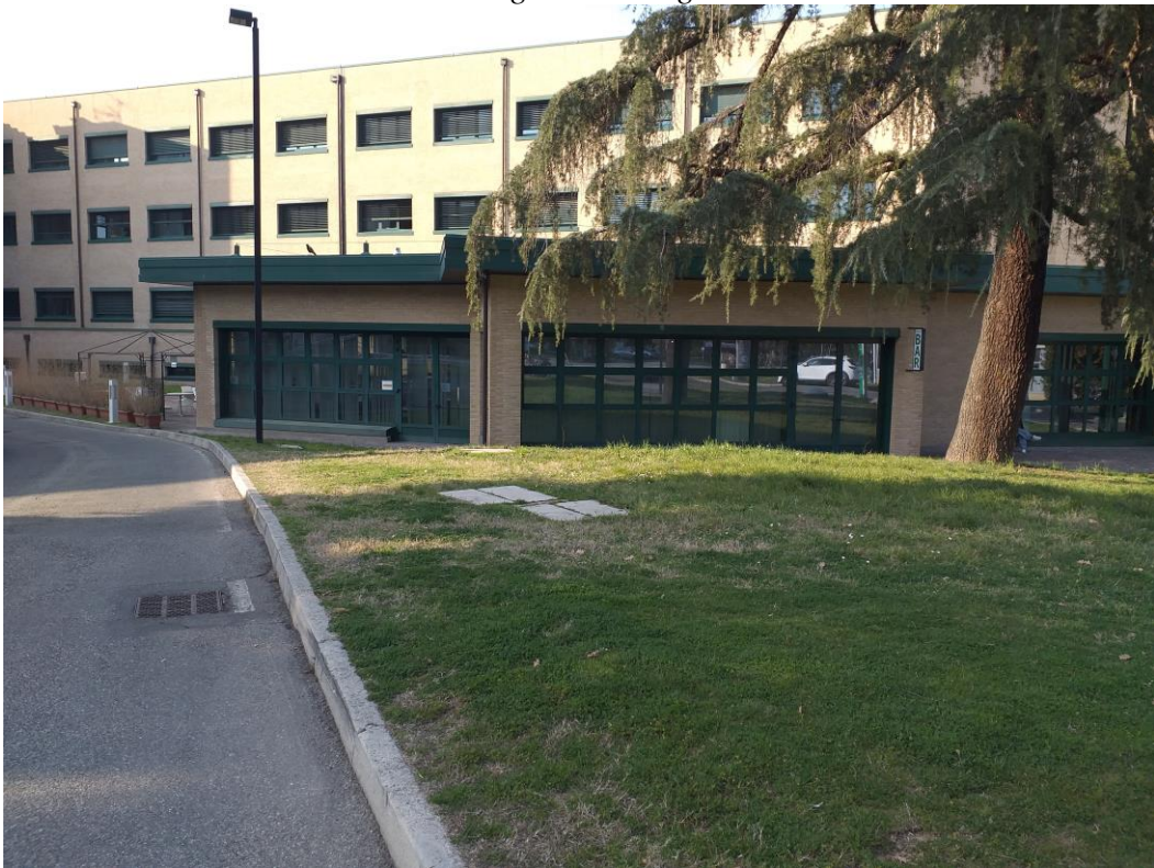
Foto 2 - Ala edificio attualmente dedicata al Bar
