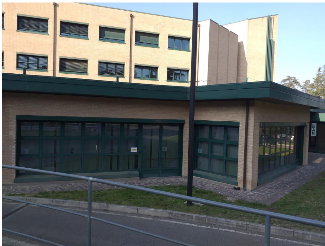
Foto 3 - Ala edificio attualmente dedicata al Bar
